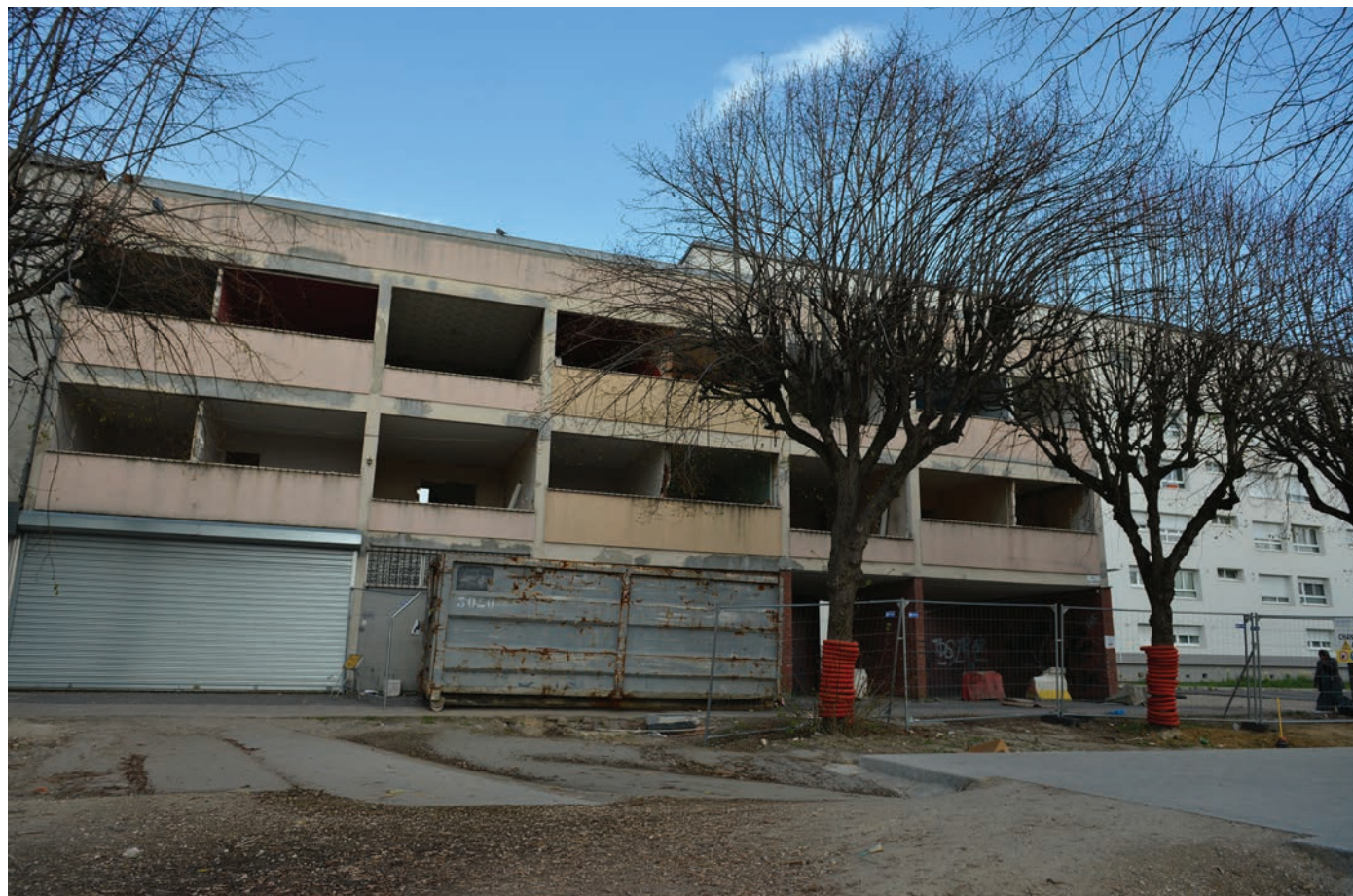
Une partie du bâtiment Einstein qui va être démolie.
