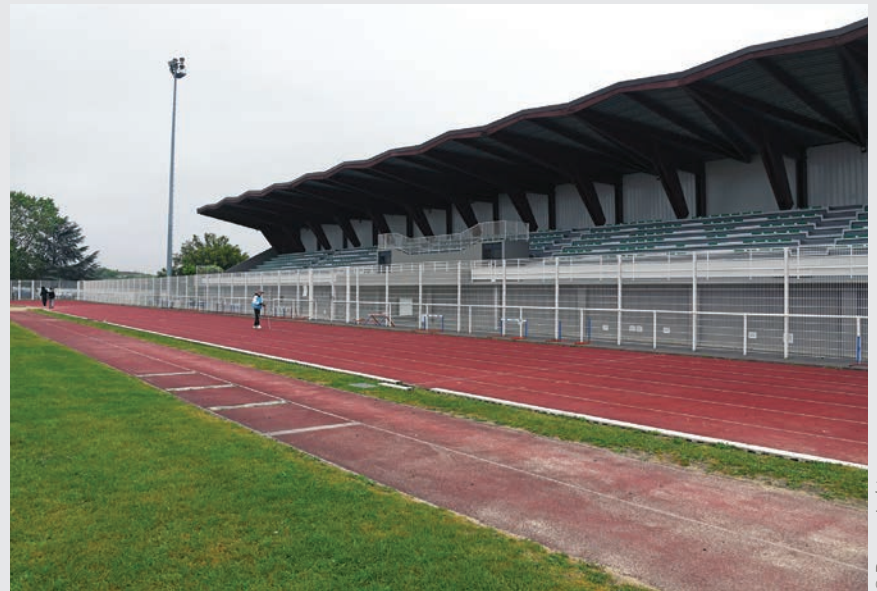
Après les travaux des tribunes, la Plaine Delaune va faire l'objet d'une réhabilitation.
