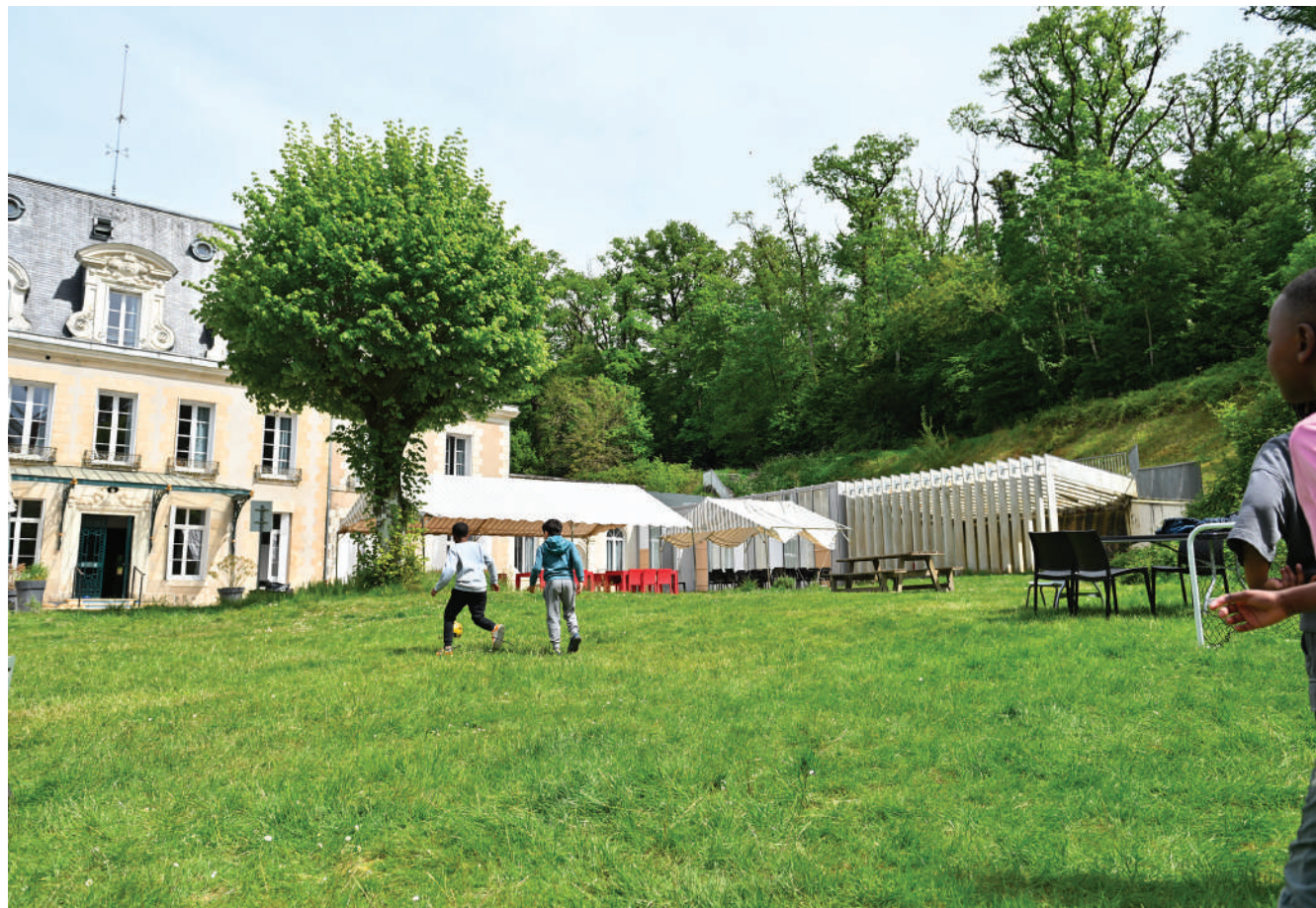
554 000 euros votés pour poursuivre la réhabilitation du château de Villiers-sur-Loir
